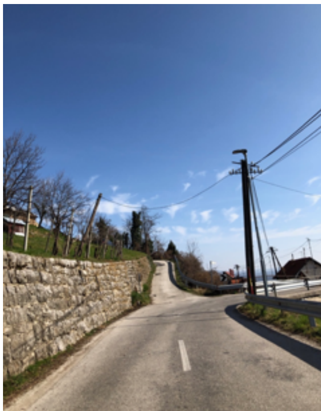
Postajališče pri mostu je nevarno za vstop in izstop učencev.
